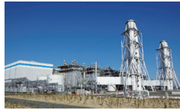
西名古屋火力発電所 (株式会社JERA様) Nishi-Nagoya Thermal Power Station (JERA Co., Inc.)
