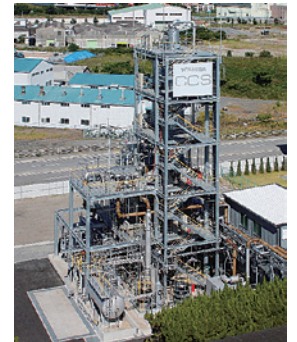
三川CO 2 分離回収パイロットプラント Mikawa PCC Pilot Plant (Post-Combustion Capture)
