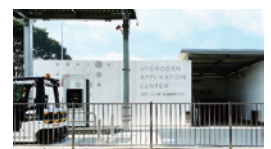
水素エネルギー活用センター Hydrogen application center
