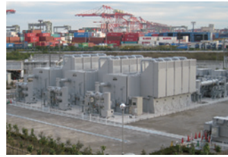
275kV-300MVAガス絶縁変圧器 (東京電力パワーグリッド株式会社大井ふ頭変電所) 275kV-300MVA Gas Insulated Transformer (Oi Futo Substation of TEPCO Power Grid, Inc.)
