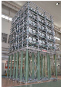
MMC方式を適用した 自励式変換器バルブ MMC ※1 Based VSC Valve ※2 *1 MMC : Modular Multilevel Converter *2 VSC : Voltage Sourced Converter
