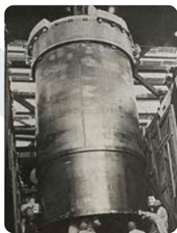
福島第一原子力発電所
