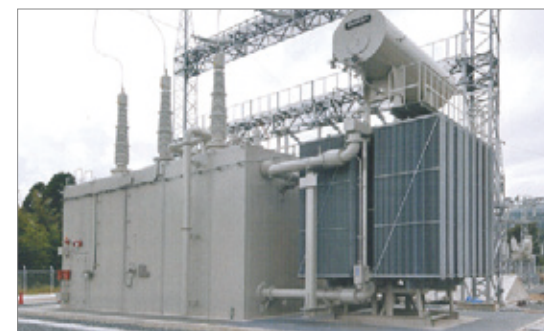
●60MVA-220kV き電用変圧器（ルーフデルタ結線）
