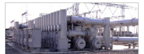
●東京電力パワーグリッド(株)/新古河変電所 300kV GIS
