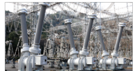
●東京電力パワーグリッド(株)/新富士変電所 550kV単体GCB
