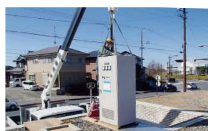
更新工事では、移動式クレーンなどを用いて既設機器を撤去します。
