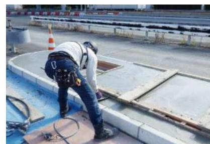
料金所レーンに機器を増設する場所の基礎工事（コンクリート打設）の現場監督も私の仕事です。
