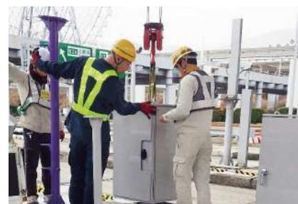
移動式クレーンを使って、機器の搬入・据付を行います。
