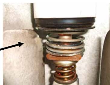
図 7. 清掃箇所（シャフト部）
