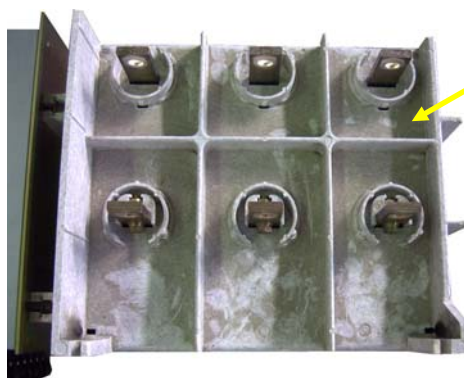
絶縁バーヤ表面 (塵埃の除去)
