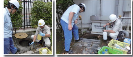
最終放流水質調査の様子
