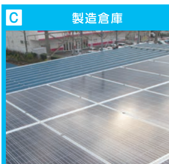
C 製造倉庫 ●パネル容量: 11.13kW(東芝 多結晶 265W×42枚) ●PCS容量 : 10kW(安川電機製 10kW×1式) ●金具 : 重ね折板用架台(動力製)
