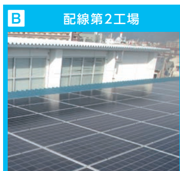
B 配線第2工場 ●パネル容量: 22.26kW(東芝 多結晶 265W×84枚) ●PCS容量 : 20kW(安川電機製 10kW×2式) ●金具 : 重ね折板用架台(動力製)
