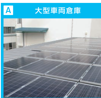
A 大型車両倉庫 ●パネル容量: 11.13kW(東芝 多結晶 265W×42枚) ●PCS容量 : 10kW(安川電機製 10kW×1式) ●金具 : ハゼ折板用金具(東芝製)
