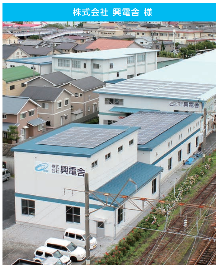
B 配線第2工場 ●パネル容量: 22.26kW(東芝 多結晶 265W×84枚) ●PCS容量 : 20kW(安川電機製 10kW×2式) ●金具 : 重ね折板用架台(動力製)
