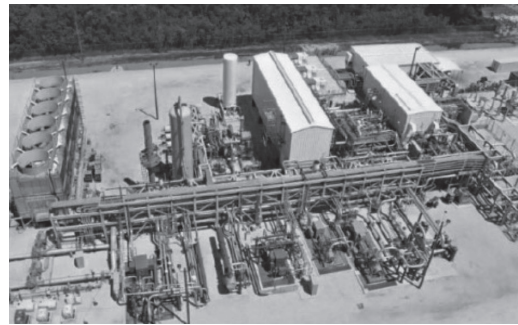
写真提供: NET Power社, McDermott社 (a) パイロットプラント
