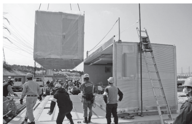
図6. 収納ハウスの据え付け
