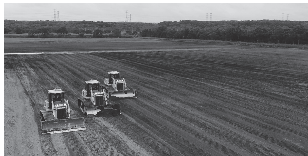
図6. ICTブルドーザーによる施工
