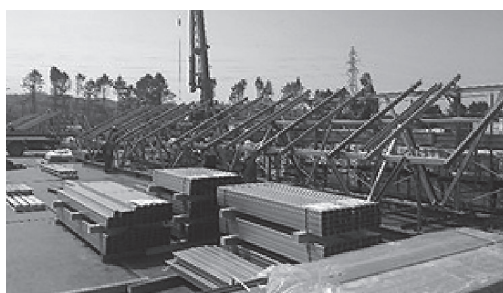
図7. アレイ架台の組立ヤード
