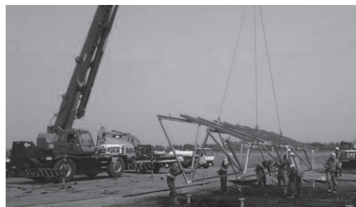
図8. アレイ架台の据え付け
