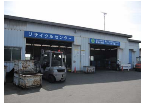
リサイクルセンターの外観
