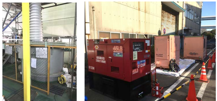
低濃度 PCB 含有変圧器の課電洗浄風景
