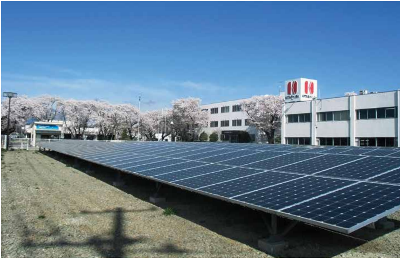
太陽光発電システムと本社事務所
