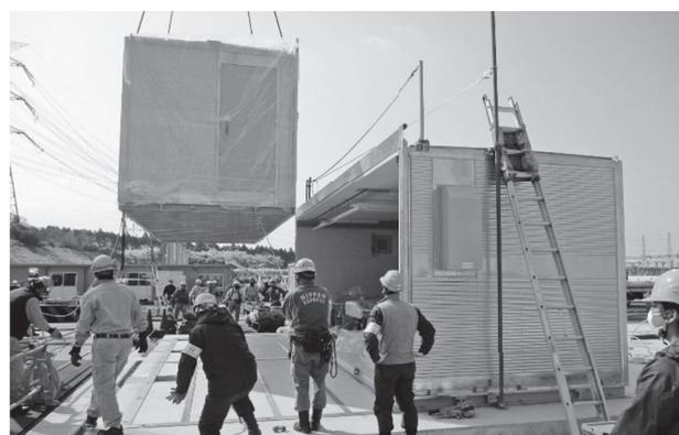
図6. 収納ハウスの据え付け
