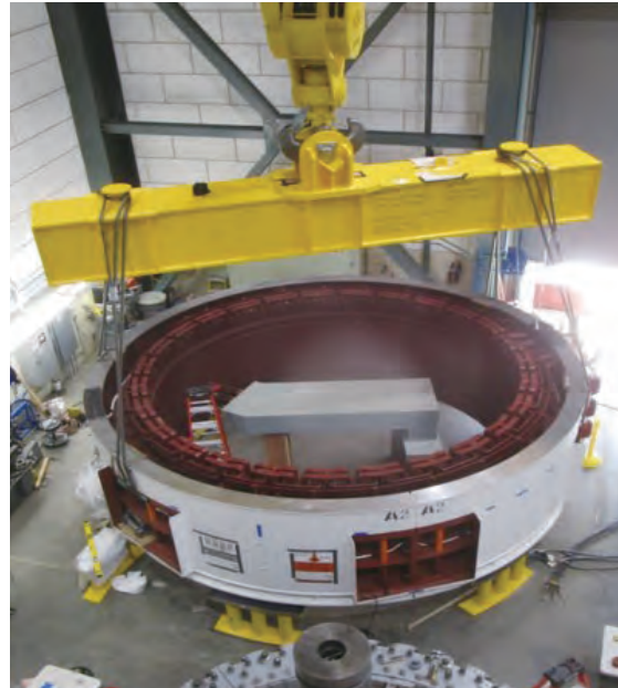
ブルームサ発電所 1 台目発電機固定子のつり込み Installation of first generator stator at Blue Mesa Hydro Power Plant, U.S.A.
