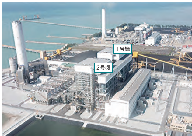
マレーシア ジマイースト発電所の全景
