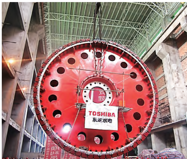
初号機発電機ローターのつり込み Installation of first generator rotor at Qianwei Power Station, China
