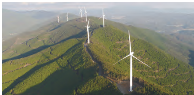
8基の2 MW風車から成る僧都ウィンドシステム
