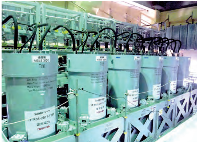
SARRY™ II を構成するろ過フィルターと吸着塔
