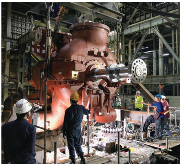
高中圧タービンの据付作業
