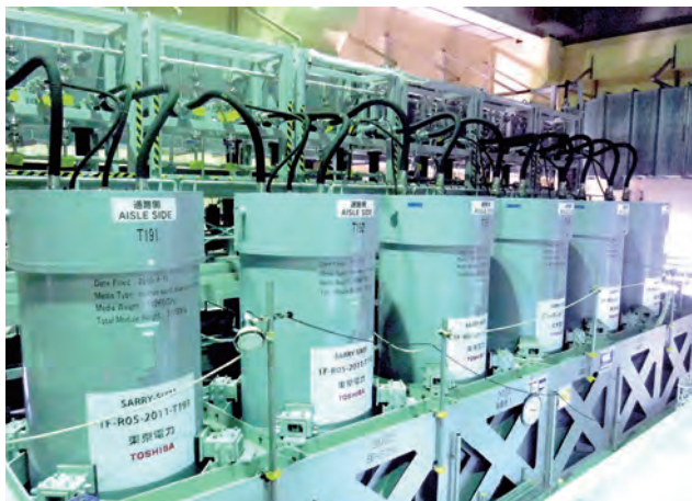
SARRY™ II を構成するろ過フィルターと吸着塔
