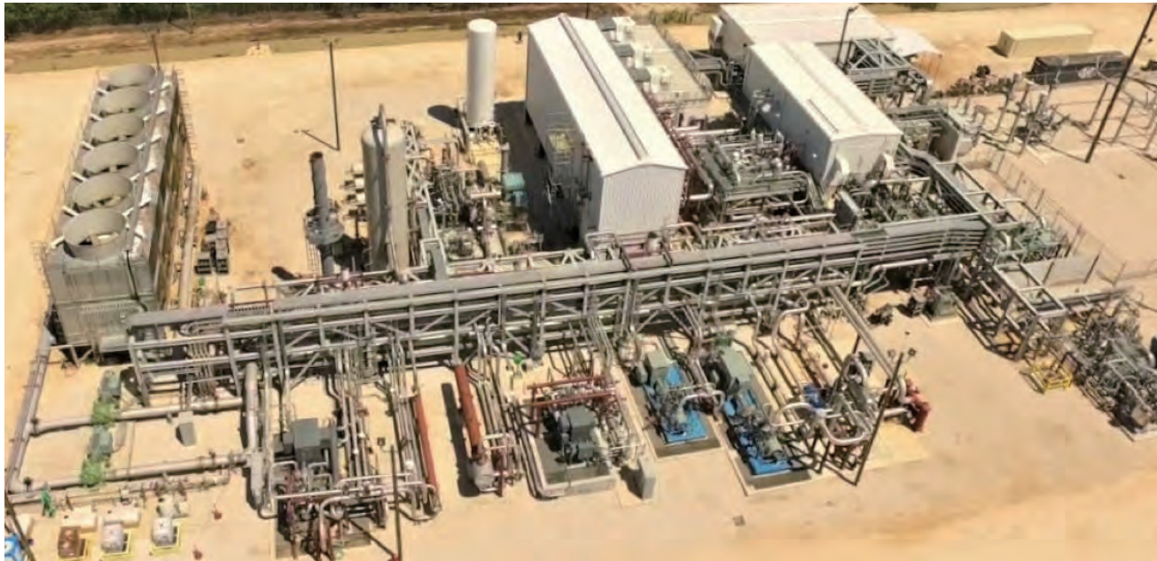
超臨界CO 2 サイクル発電システムのパイロットプラント Supercritical carbon dioxide (CO 2 ) cycle demonstration power plant, U.S.A.
