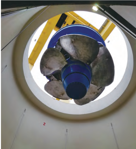
ウェルズ発電所 3 台目カプラン水車ランナのつり込み Installation of third Kaplan turbine runner at Wells Hydro Power Plant, U.S.A.
