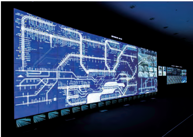
東日本高速道路(株) 関東支社 道路管制センターシステム Traffic control center system for Kanto Regional Head Office of East Nippon Expressway Co., Ltd.
