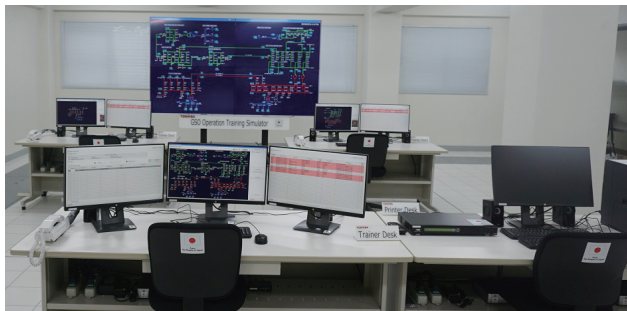
変電所運転訓練シミュレーター
