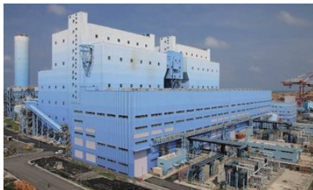
大林火力発電所新1, 2号機の全景
