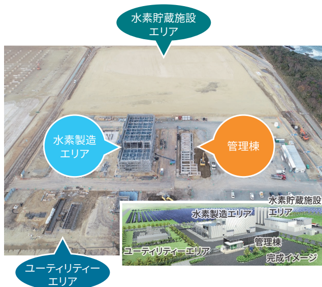
建設工事が開始された水素プラント Installation site of large-scale hydrogen energy system using renewable energy
