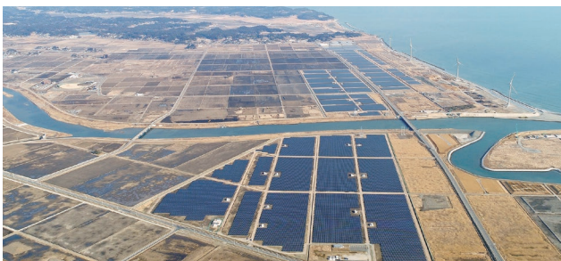
南相馬真野右田海老太陽光発電所(太陽電池モジュール容量59.9 MW) Minamisoma Mano-Migita-Ebi Solar Power Plant in Fukushima, Japan
