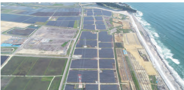
南相馬原町東太陽光発電所(太陽電池モジュール容量32.3 MW) Minamisoma Haramachi-Higashi Solar Power Plant in Fukushima, Japan
