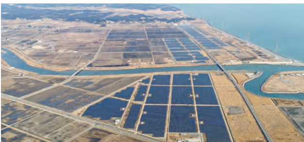
南相馬真野右田海老太陽光発電所(太陽電池モジュール容量59.9 MW) Minamisoma Mano-Migita-Ebi Solar Power Plant in Fukushima, Japan
