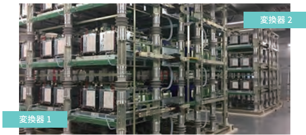
実証検証を行った自励式変換器 Voltage source converters used in demonstration tests
