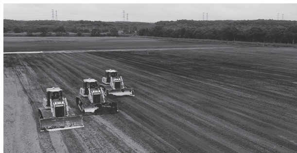
図6. ICTブルドーザーによる施工
