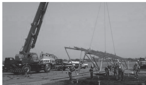
図8. アレイ架台の据え付け
