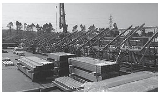
図7. アレイ架台の組立ヤード
