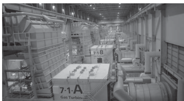
図3. ガスタービン発電機
