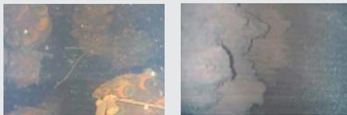
構造物が破損している様子 溶融物が固化したと思われるもの
