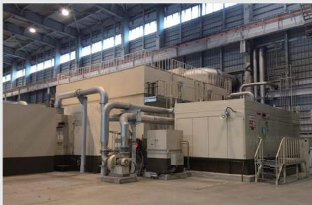
更新後のガスタービンエンクロージャーと燃料ガス弁室
