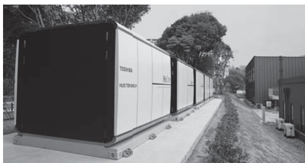
図8. H 2 One™リゾートモデルの設置例 — 自立してホテルに電力を供給し、100%自給自足できるシステムである。 Example of H 2 One™ resort model
