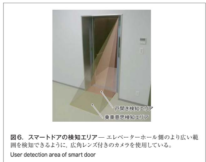
図6. スマートドアの検知エリア — エレベーターホール側のより広い範囲を検知できるように、広角レンズ付きのカメラを使用している。
