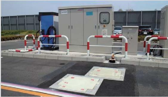
44 kW ワイヤレス急速充電システム用地上装置
