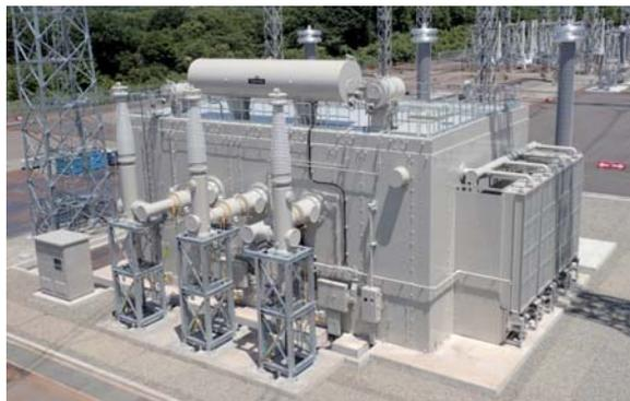
関西電力(株)北摂変電所 500kV-1,000MVA分解輸送変圧器
