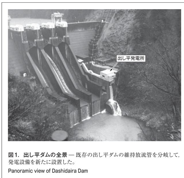
図1. 出し平ダムの全景 — 既存の出し平ダムの維持放流水管を分岐して、発電設備を新たに設置した。
