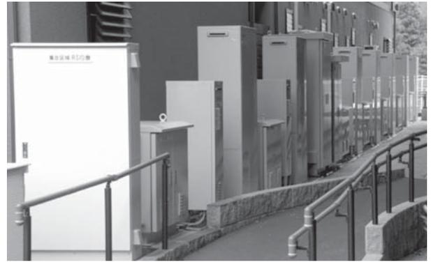
図9. 北九州水素タウンに設置した純水素FCシステム — 北九州水素タウンのコンドミニアムなどに設置した純水素FCシステムで、12台を設置して検証を行った。
