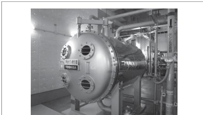
図6. 北千葉浄水場に設置されたTGOGS™ — 2014年12月から運転を開始し、より安全で良質な水道水を供給している。
