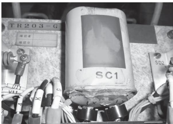
図3. オイルコンデンサの劣化 — 経時変化によるオイルのガス化でケースが膨張する。
