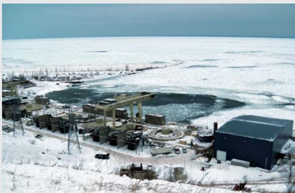
▲ ラディントン揚水発電所の全景 Ludington Pumped Storage Plant, U.S.A.
