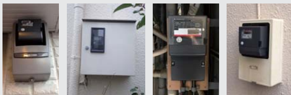
▲ スマートメーター (当社製 920 MHz 無線通信部内蔵) の設置例 Examples of installation of smart meter (920 MHz wireless communication)
