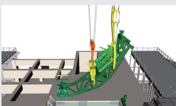
▲ 燃料交換機つり上げのシミュレーション Simulation of fuel handling machine removal
