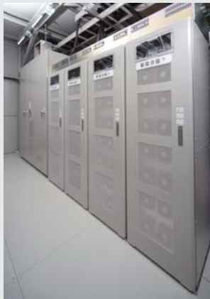
◀ 運河駅構内に設置された 回生電力貯蔵装置 Traction energy storage system (TESS) for Unga Station of Tobu Railway Co., Ltd.
