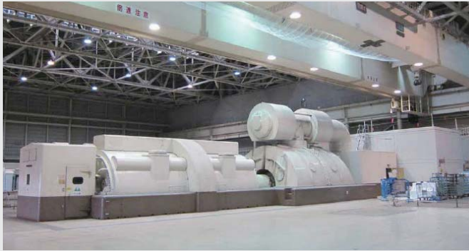
▲ 更新後の7-2軸パワートレイン（ガスタービン、蒸気タービン、及び発電機） Refurbished stage 7-2 power train for Yokohama Power Station of Tokyo Electric Power Co., Inc.
