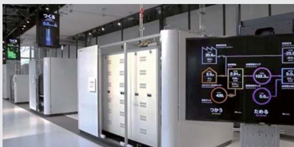
▲ 水素エネルギー研究開発センターの内部のようす Interior of Toshiba Hydrogen Energy R&D Center
