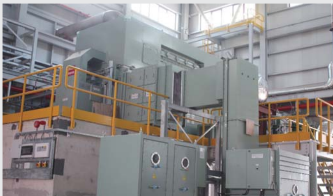
▲ アラシェヒル地熱発電所 タービン発電機 Turbine generator for Alasehir Geothermal Power Plant, Turkey
