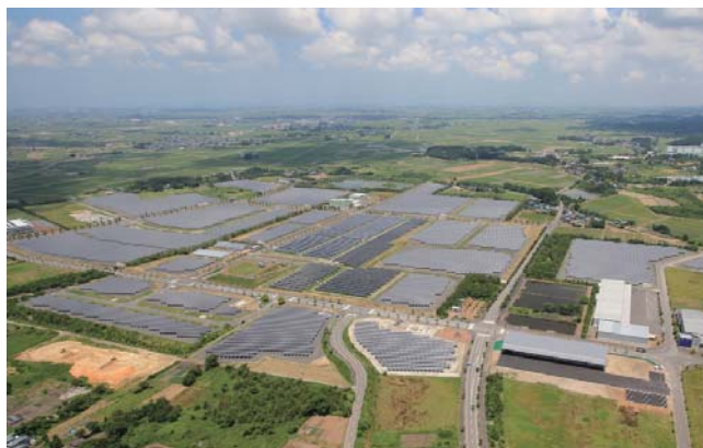
新潟東部太陽光発電所 3号系列 Niigata East Solar Power Generation Plant Unit 3
