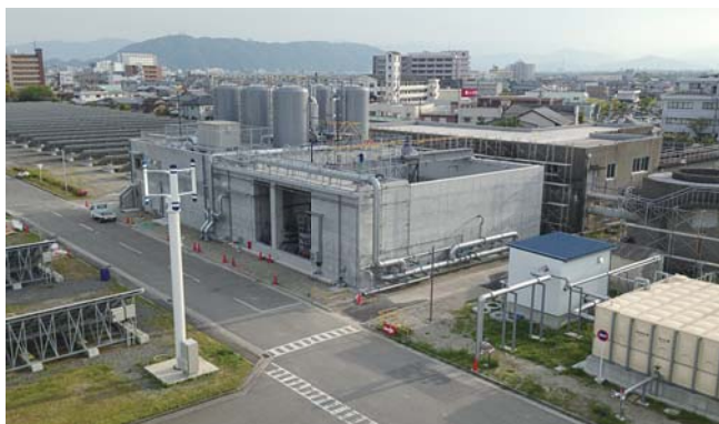
日清紡ペーパー プロダクツ (株) 徳島事業所の給水場
