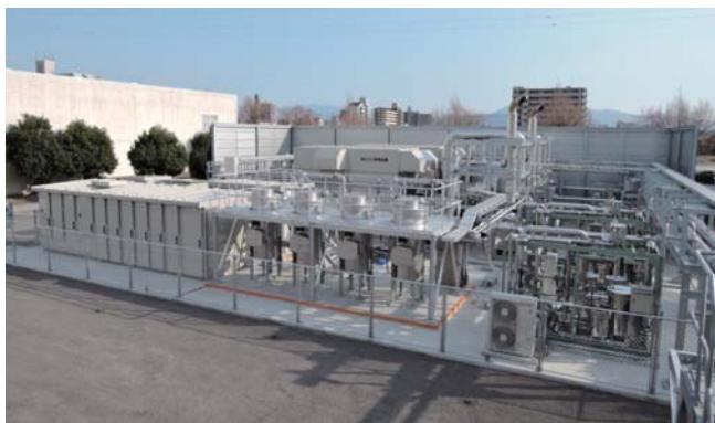
松山市中央浄化センターの消化ガス発電設備
