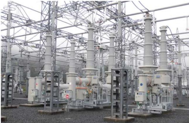
新形 300 kV ガス複合形開閉装置
