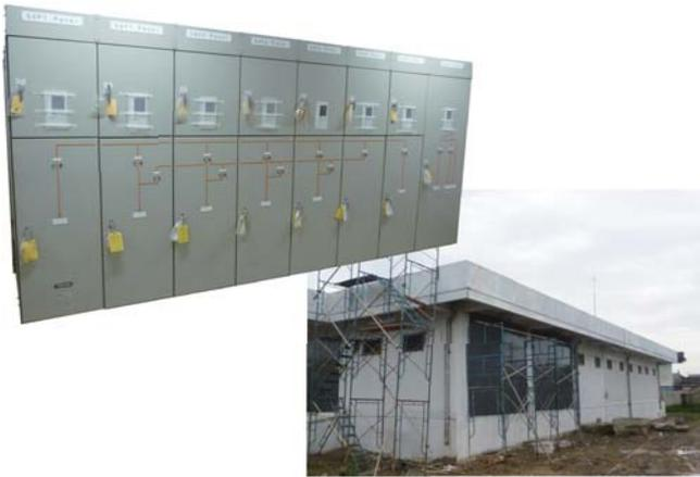
電気鉄道用直流変電所への据付けが完了した直流スイッチギヤ
