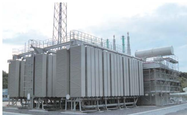
九州電力(株) 東九州変電所 500 kV-1,500 MVA ASA 変圧器
