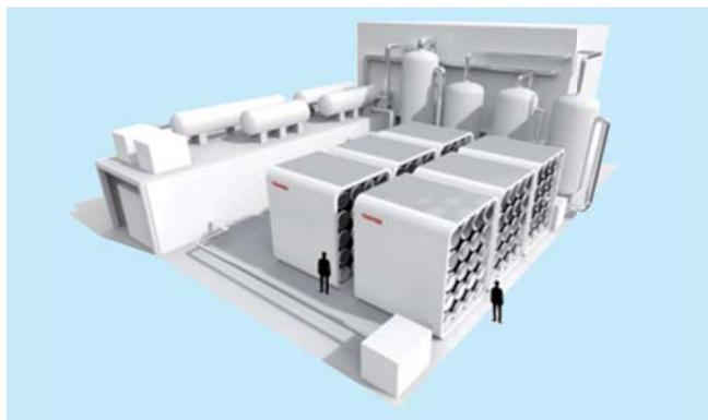
5 MWe級 水素電力貯蔵装置(蓄電容量 32 MWh)
