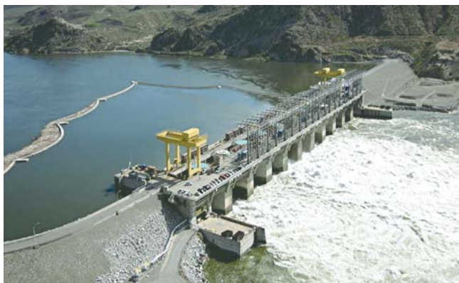
ウェルズ水力発電所
