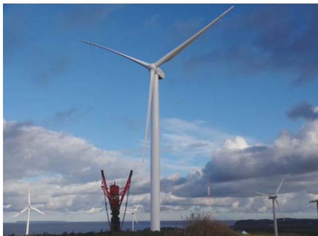
据付完了後の風車
