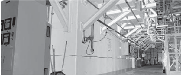
図7. レーザスキャンデータの例 — 写真のように見えるが点群データであり、それぞれの点がX、Y、Zの位置情報を持つ。 Example of laser scanning data
