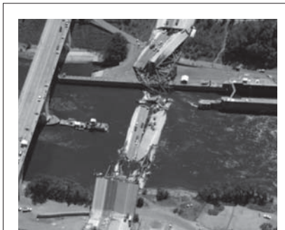
出典：米国ミネアポリス橋梁崩壊事故に関する技術調査団「米国ミネアポリス橋梁崩壊事故に関する技術調査報告」 (1)
