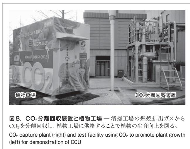
図8. CO<sub>2</sub>分離回収装置と植物工場 — 清掃工場の燃焼排出ガスからCO<sub>2</sub>を分離回収し、植物工場に供給することで植物の生育向上を図る。
