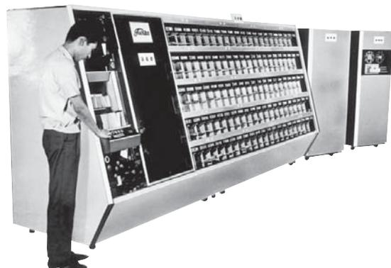
図1. 世界初の実用手書き郵便番号読取区分機 TR-4 — 独自のOCR認識処理技術により世界初の自由手書き数字の読取りに成功した。
