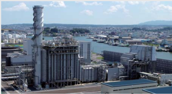
▲ 東北電力(株) 八戸火力発電所第5号機 Hachinohe Thermal Power Station Unit 5 of Tohoku Electric Power Co., Inc.
