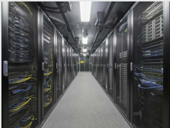
▲ 屋内モジュール型データセンターのモジュール内部 Toshiba Indoor Modular Data Center (interior view)
