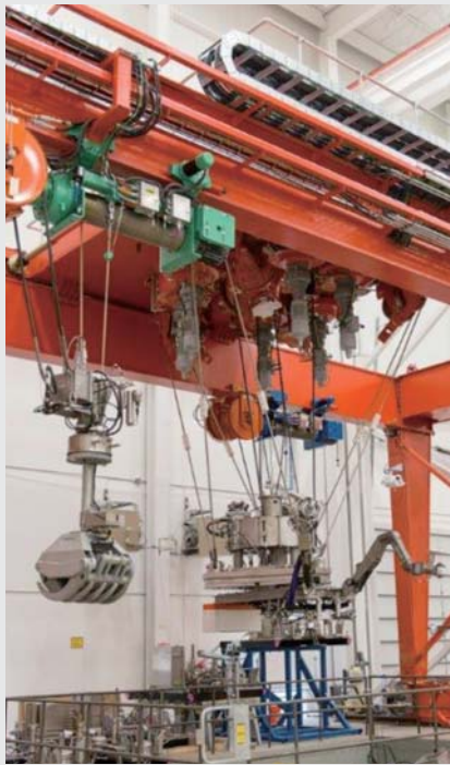
▲ 燃料取出しシステム Fuel removal system
