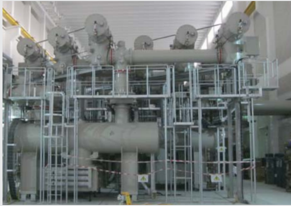
▲ クウェート アズールノース "Z" 400/300 kV 変電所 420 kV-80 kA GIS 420 kV-80 kA gas-insulated switchgear (GIS) for Al-Zour North "Z" 400/300 kV Substation, Kuwait
