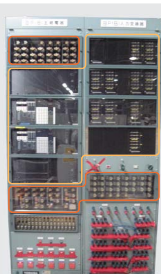
▲ 保護リレー装置の交換部位の例 Example of retrofit parts for protection relay equipment
