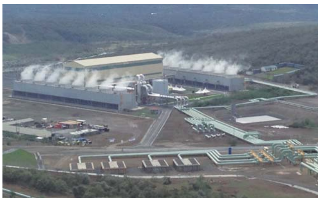
ケニア地熱発電所 Geothermal Power Plant, Kenya
