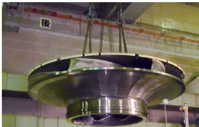
九州電力(株) 大平発電所のランナ取り付け
