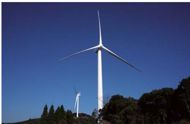
据付工事の完了した新長島黒ノ瀬戸風力発電所 Shin-Nagashima Kuronoseto Wind Power Plant of Sigma Power Janex Co., Ltd.
