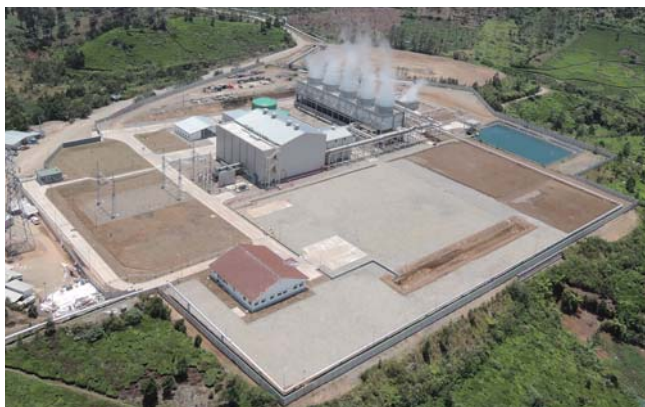
パトゥーハ地熱発電所 1号機 Patuha Geothermal Power Plant Unit 1, Indonesia
