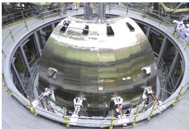
JT-60SA 真空容器 40°セクタ2体の組立て
