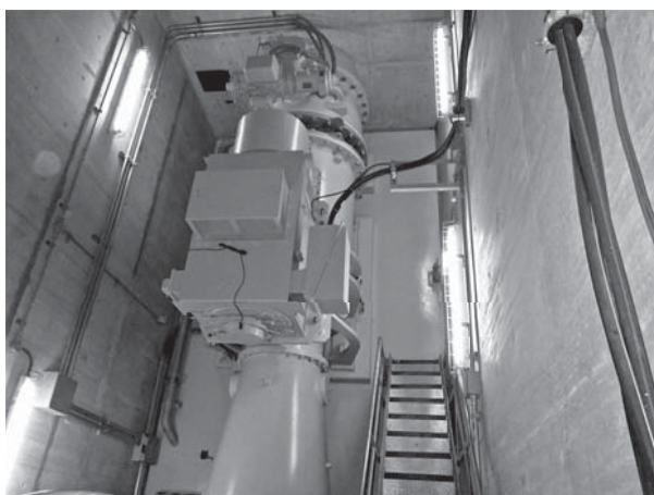
図2. マイクロ水力発電装置 — 東北電力（株）飯野発電所へ適用した例であり、低落差地点にも適用できる。
