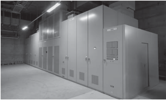
図8. サイリスタ始動装置 — 当社にとって12台目の納入となるサイリスタ始動装置である。
