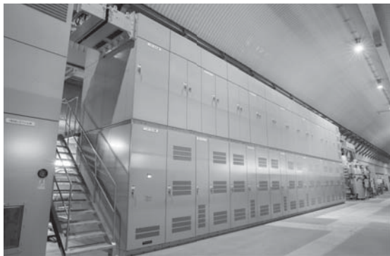
図7. IEGT変換器 — 二次励磁装置にIEGT変換器を適用することで、スペース及び損失を従来のGTO変換器よりも大幅に低減できた。
