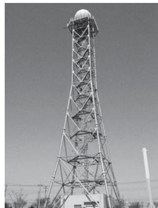
図1. 埼玉県流域下水道 降雨情報システムの雨量レーダー 雨量レーダにより面的な降雨情報を高精度、高分解能、及びリアルタイムに観測できる。
