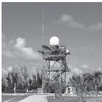
図2. フェーズドアレイ気象レーダー NICT 沖縄電磁波技術センター内の鉄塔上にレドームで覆われたアンテナを設置している。
